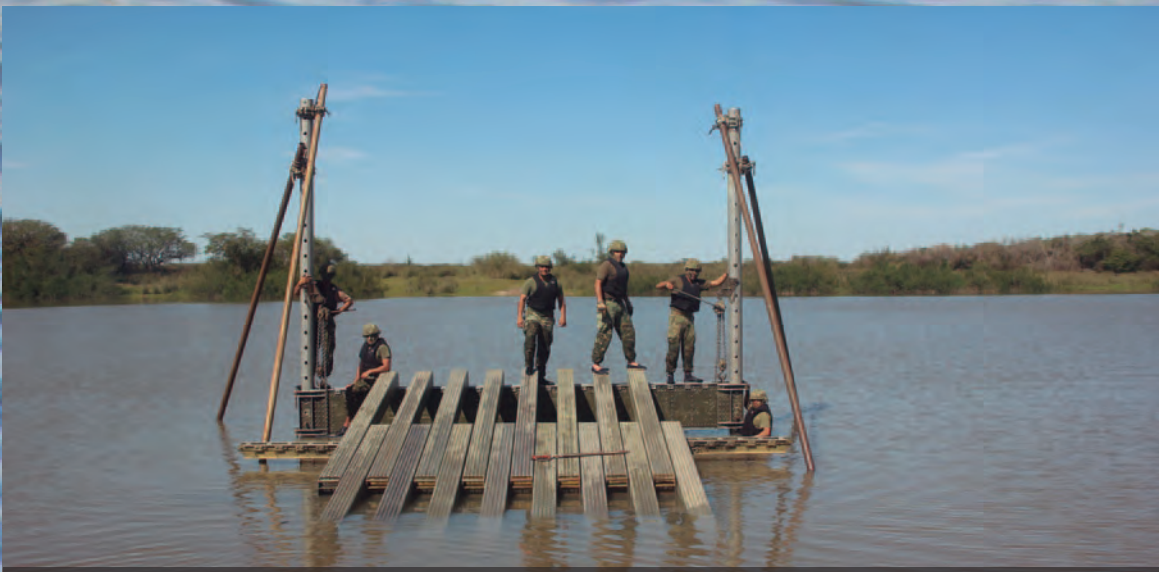
Construcción de muelle de puente M4T6 sobre caballetes.
