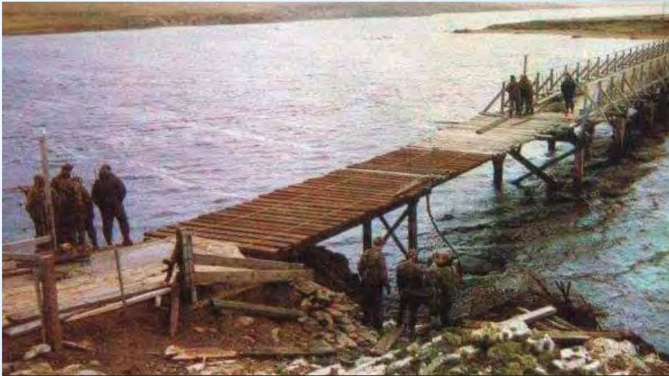
Puente Fitz Roy antes de su voladura.
